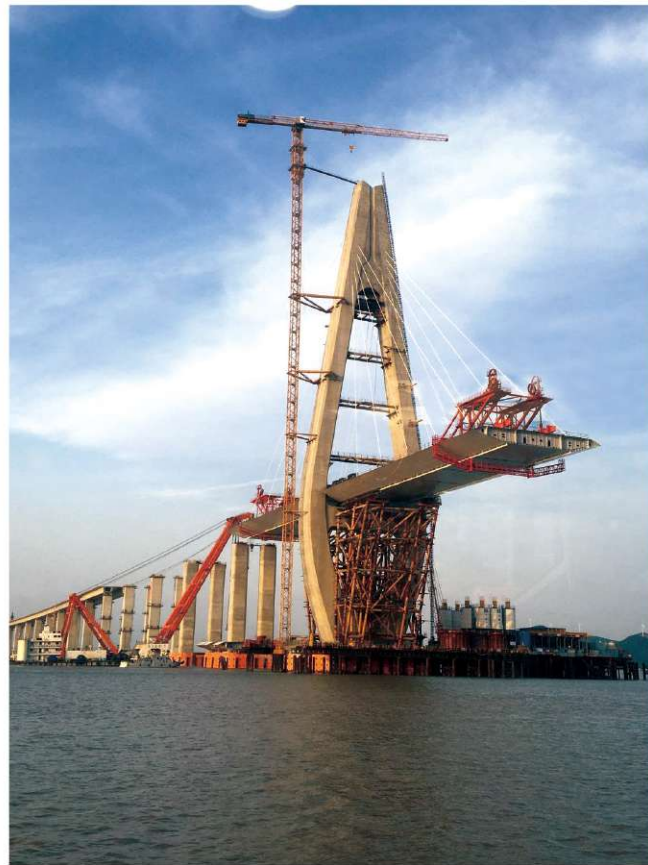
塔式起重机、架桥机(门式起重机)、 船载起重机(流动式起重机)
