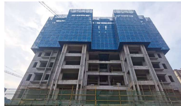
附着式升降脚手架的安全检测
