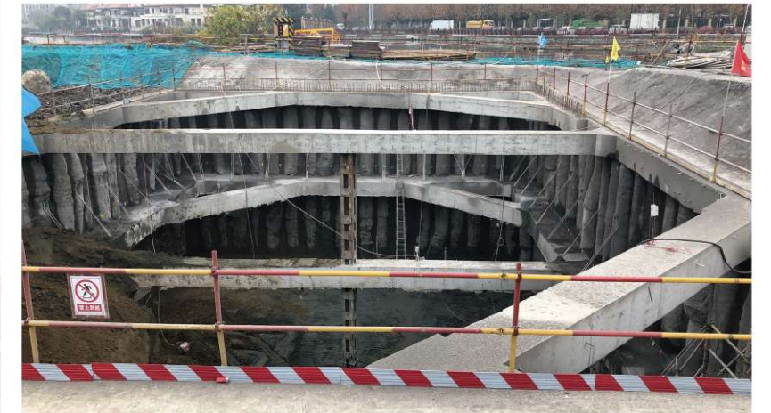
建筑施工现场深基坑支护及开挖的安全检查
