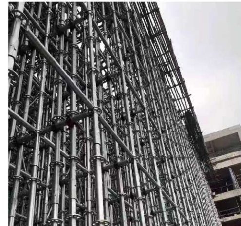
施工安全检查脚手架
